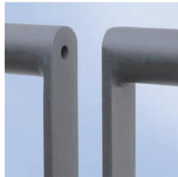
Dettagli del punto di giunzione tra la particolare piantana in ferro piatto e il tubo orizzontale.
