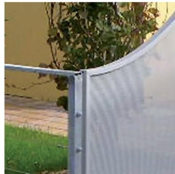
Protezione formata da moduli bordati e sostenuti da piantane in tubo quadro
